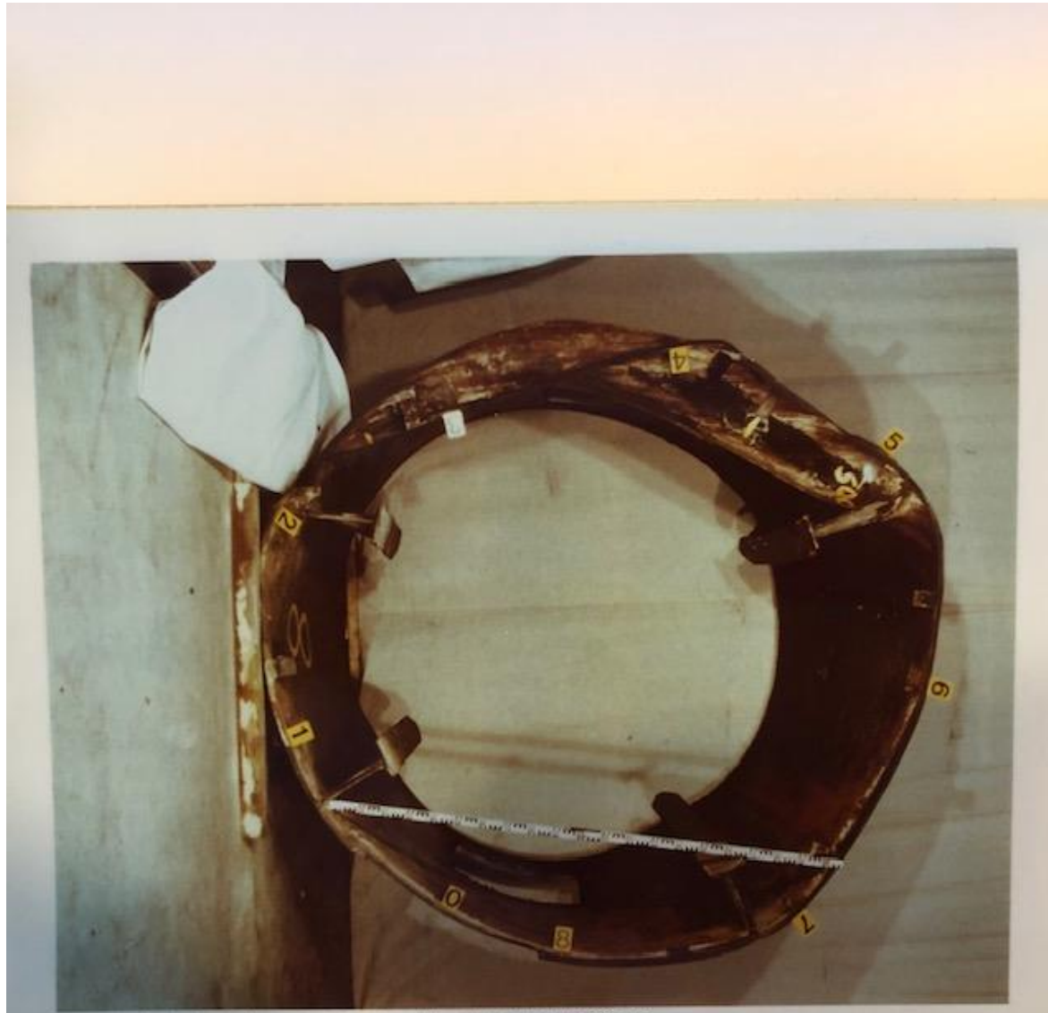
Fig. 3.4.10 Del nr. 8, fra stag DE, sett mot bruddflaten
